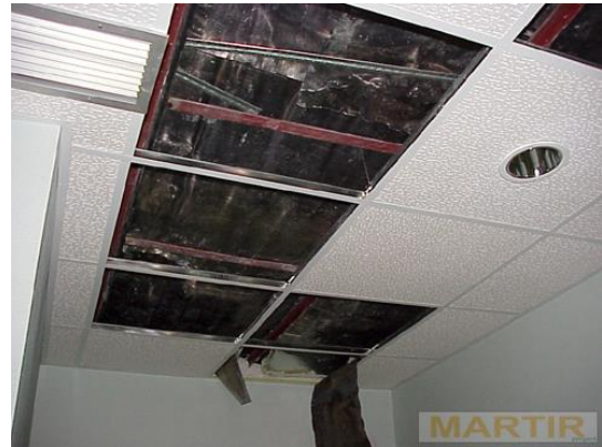
Piombatura del soffitto
